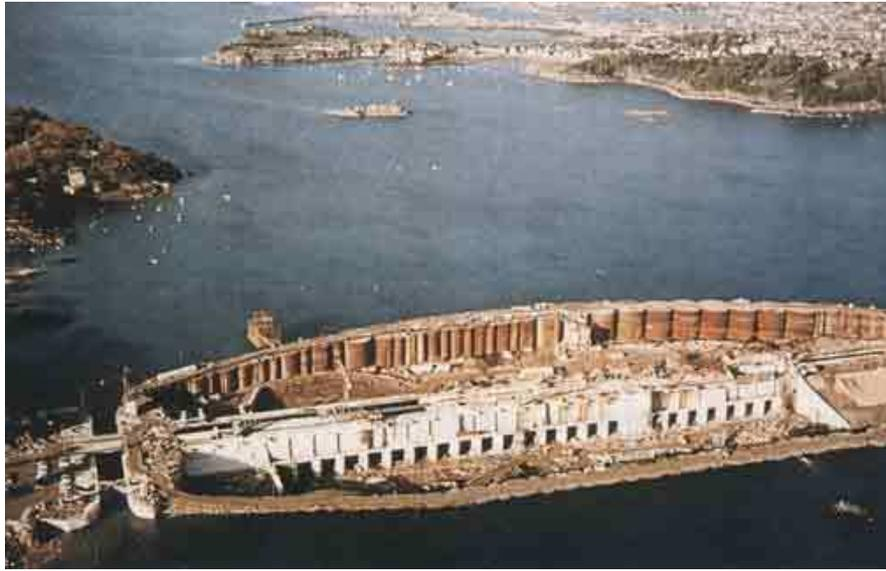
Usine marémotrice en construction à l'abri de l'enceinte.
